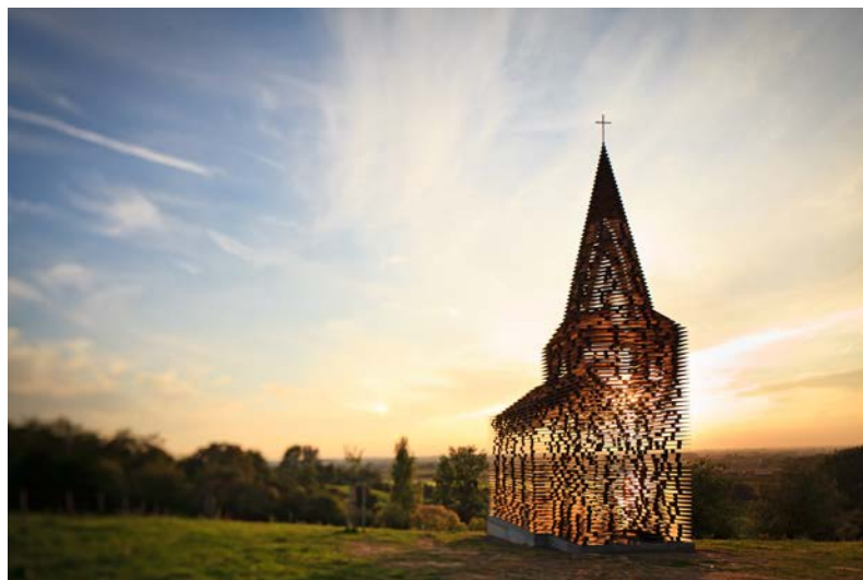
Het architectenduo Gijs Van Vaerenbergh maakte een doorkijkkerk in Borgloon. Reading between the Lines is 10 meter hoog en bestaat uit 100 op elkaar gestapelde lagen staalplaat.
